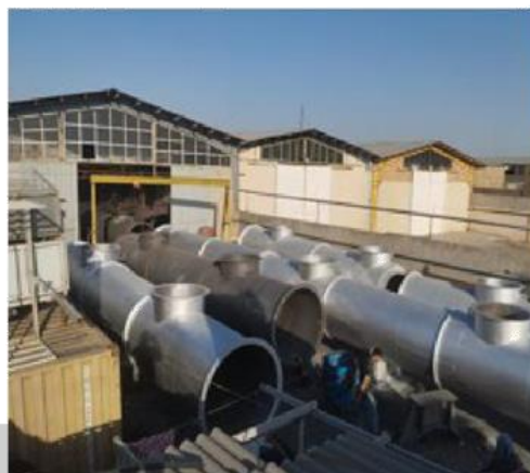
ساخت داکت جمع آوری گاز کوره شماره یک - شرکت کرین صنعت امیر کبیر
